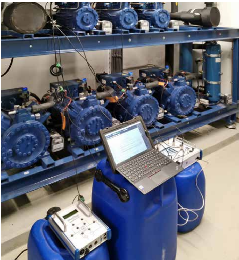
Anlagenmessung an einer CO 2 -Booster Anlage in einem Supermarkt
